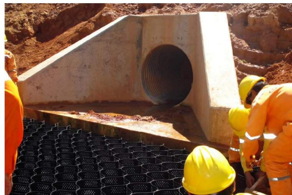
▶ *Estructuras disipadoras de energía y salidas de alcantarillas*
