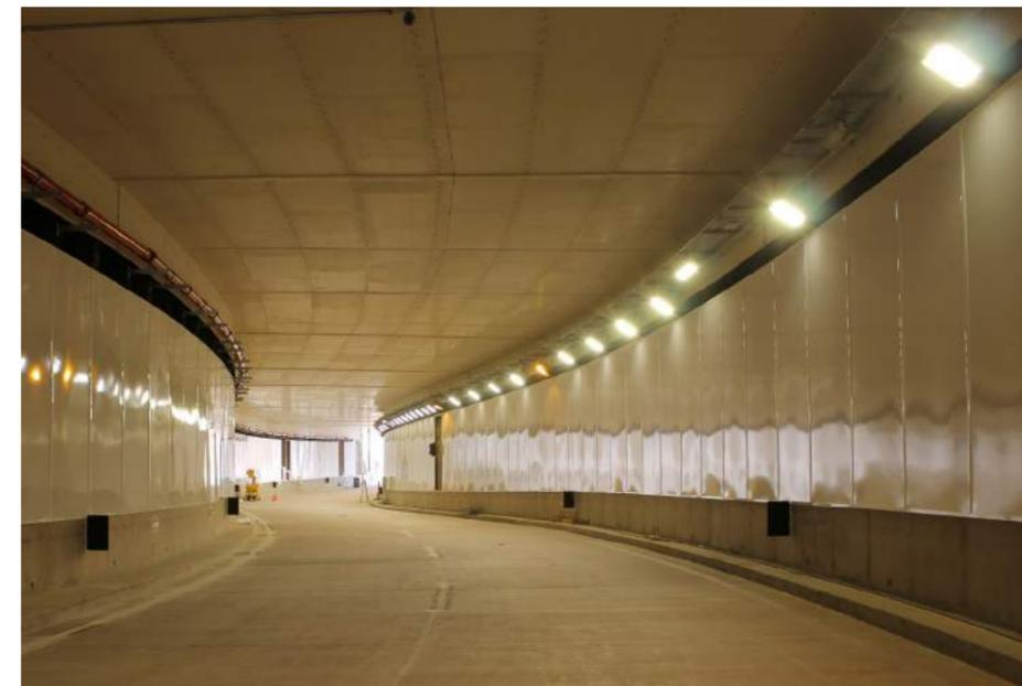
▶ Sistemas de revestimiento de túneles
