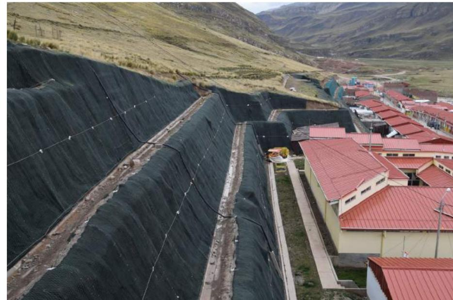
▶ *Sistemas de control de desprendimiento de rocas y estabilización de taludes*
