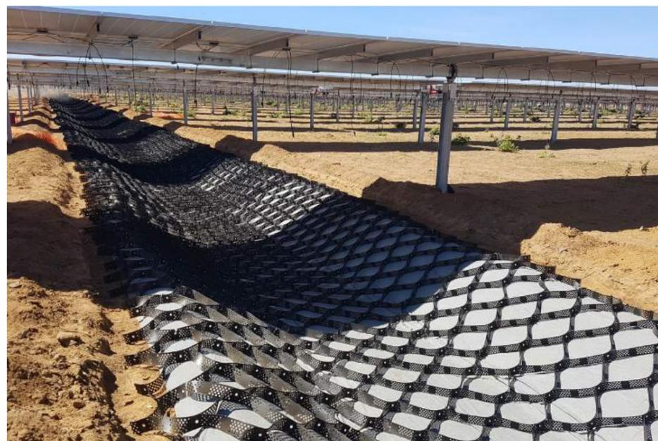
▶ *Protección de canales y taludes*
