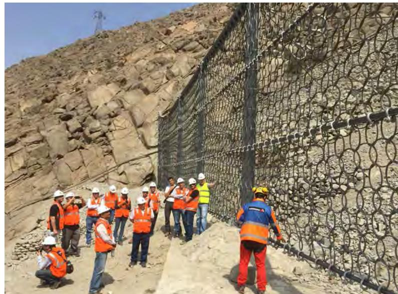
A diferencia de los muros convencionales rígidos de concreto o mampostería, las barreras dinámicas contra flujo de detritos son sistemas flexibles, conformados por redes de anillos circulares que absorben la energía de impacto y que es transmitida a los anclajes perimetrales del cauce.
